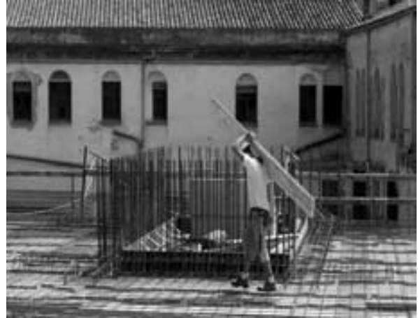
Vue d'un chantier moderne traditionnel (photo C.S.)
