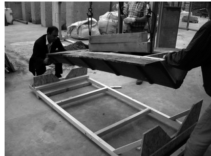
Figure 6 : Découverte de la construction en terre
